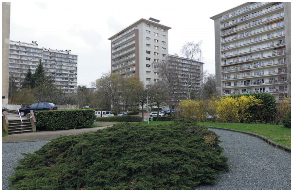
Figure 4 – Bruxelles, ensemble Etrimo d'Auderghem, 1964-1968
