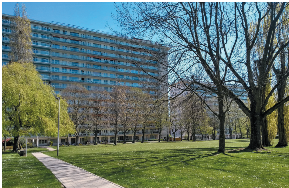
Figure 5 – Bruxelles, ensemble Etrimo de Woluwe-Saint-Lambert, 1964-1968
